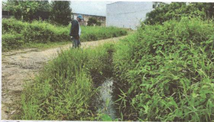
Foto 2. Canales de aguas negras del perímetro de la calle 19.
